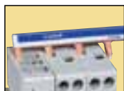
Passagem do pente de alimentação
