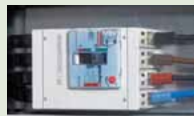
Exemplo de utilização de mangas num DPX 250 cablado
