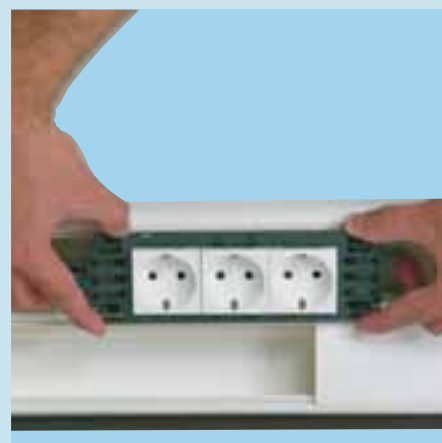
Depois de efectuadas as ligações nas tomadas Mosaic "especial DLP", basta encaixá-las na calha
